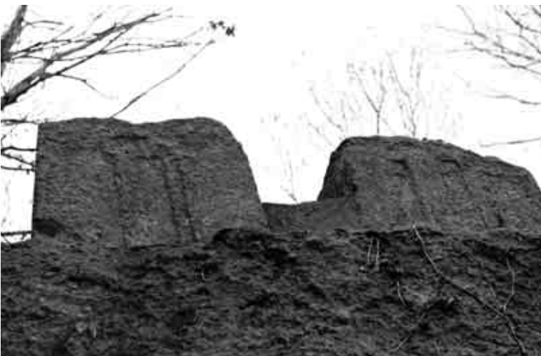
Fig. 4 La porta dorica sulla fronte esterna degli alloggiamenti (foto Angelo Pagliari)
